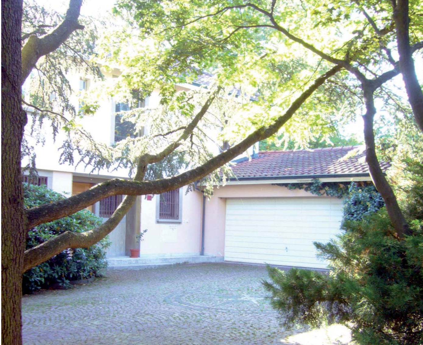
Vorplatz mit angebauter Doppelgarage
